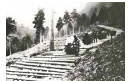
大正初期の修羅道と木馬道の状況 *修羅道は丸太を直接滑らせて運搬 *木馬道は丸太を並べた道の上に、丸太を載せたそりを通して運搬
